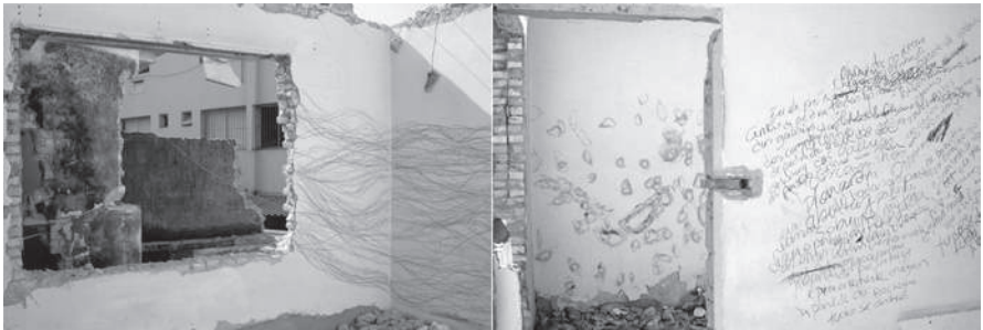
Figura 1: Desenho em demolição . Intervenções realizadas pelo artista. (Fonte: acervo do autor, 2007)
